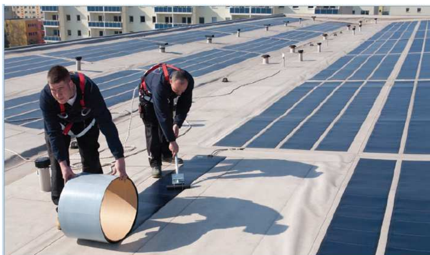
Figura 5 - Colagem dos módulos flexíveis sobre cobertura impermeabilizada
