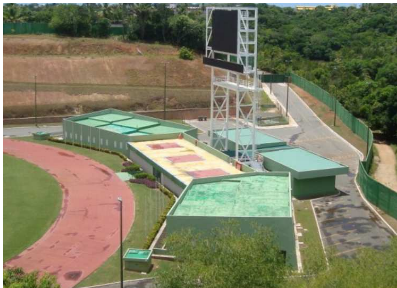
Figura 4 - Exemplo de cobertura de concreto (coberturas indicadas com os números 1 e 6 na Figura 1)
