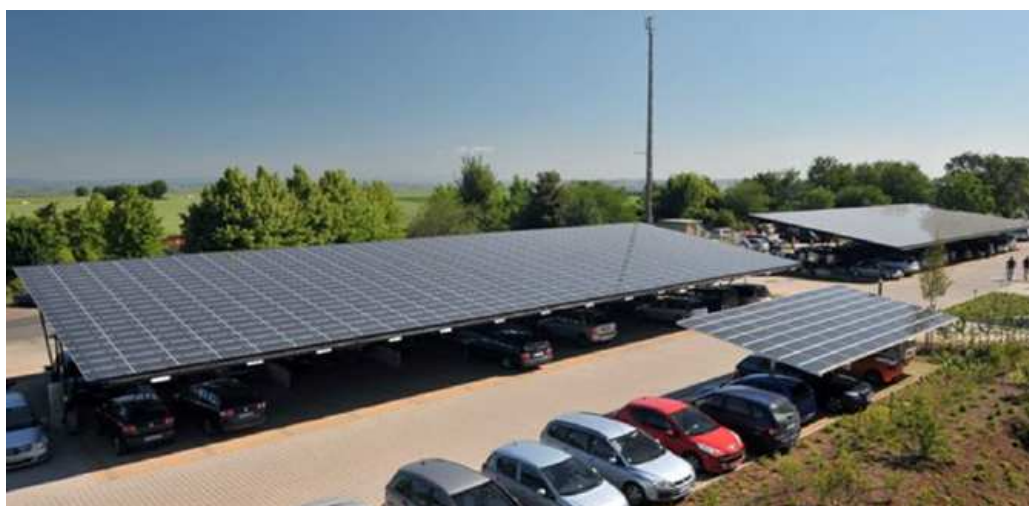
Figura 10 - Estacionamento com cobertura de módulos fotovoltaicos
