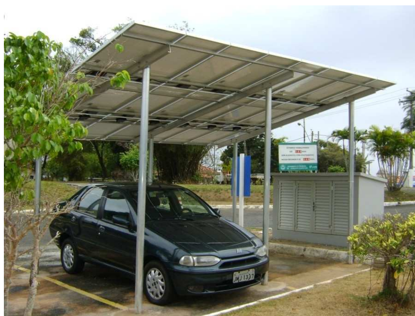
Figura 11 - Estrutura metálica de um estacionamento com cobertura de módulos fotovoltaicos
