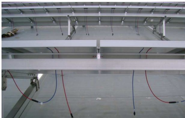
Figura 12 - Terminais elétricos e cabos, para módulos fotovoltaicos com terminais na face inferior
