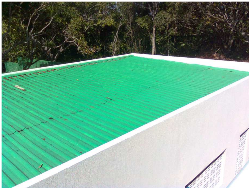
Figura 3 - Exemplo de cobertura metálica (indicadas com os números 2 e 5 na Figura 1)
