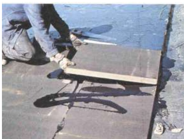
Isolation sous étanchéité
